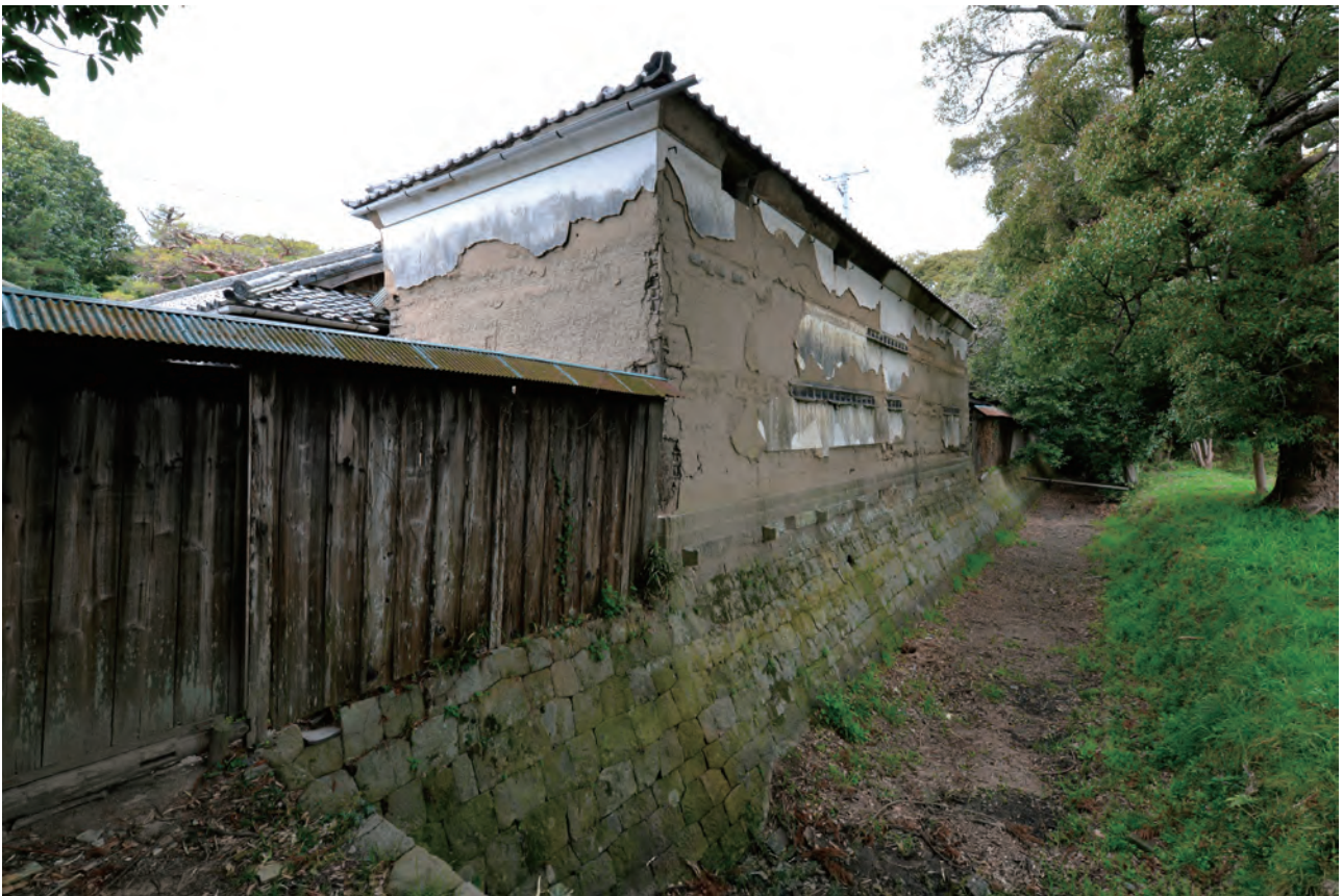
11. 東側堀及び米蔵（南東より）
