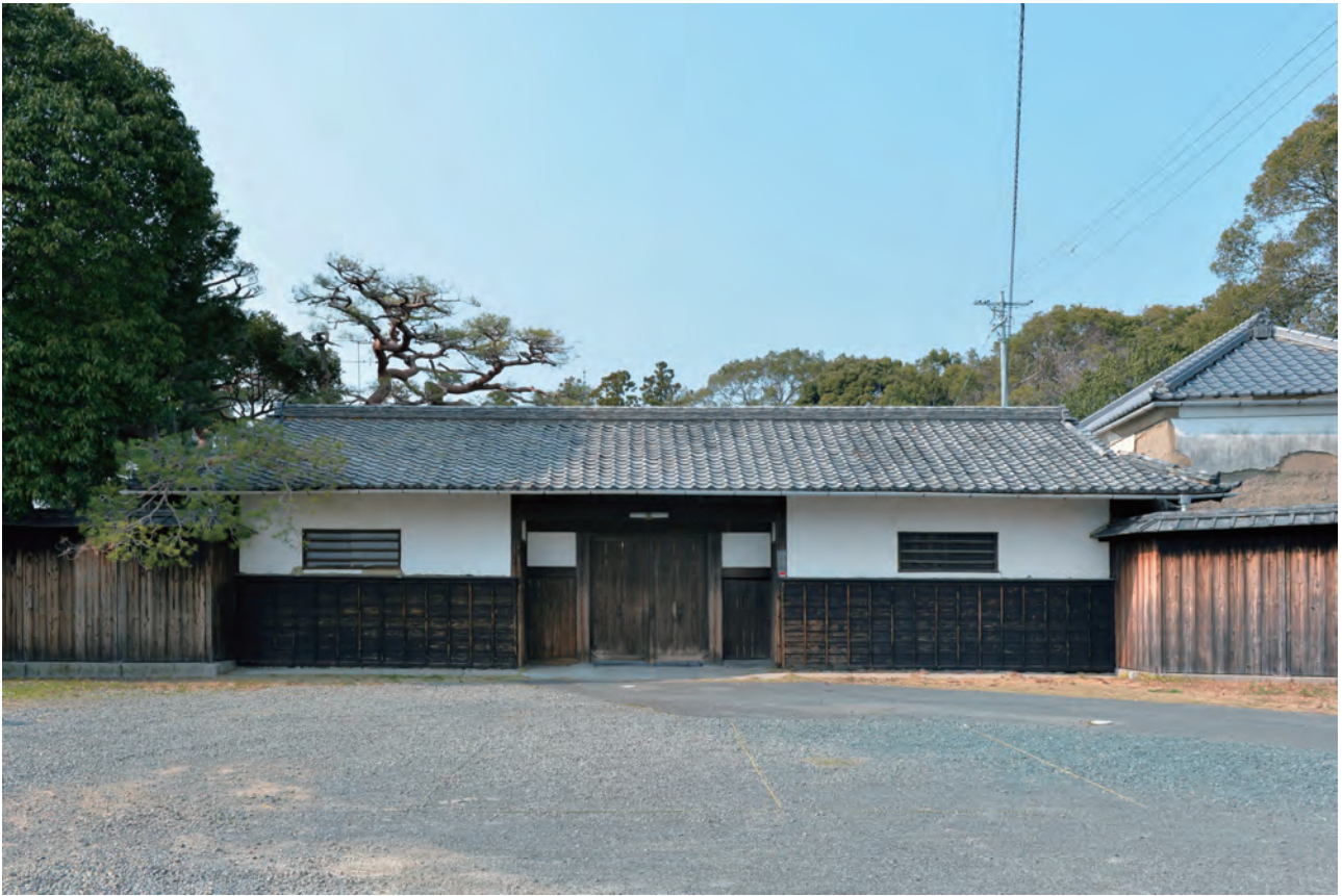
10. 長屋門 全景（南より）
