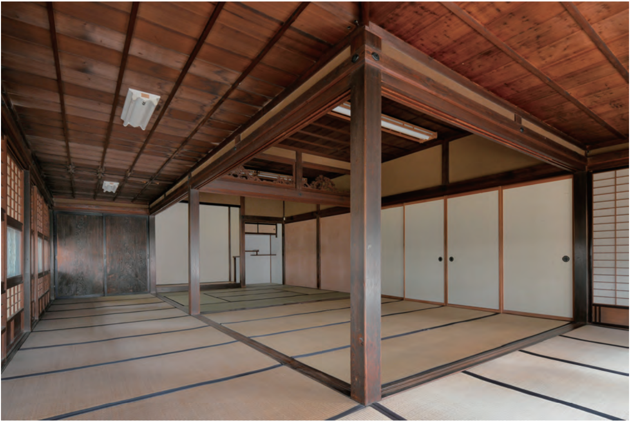
3. 主屋 表座敷及び広縁（南西より）
