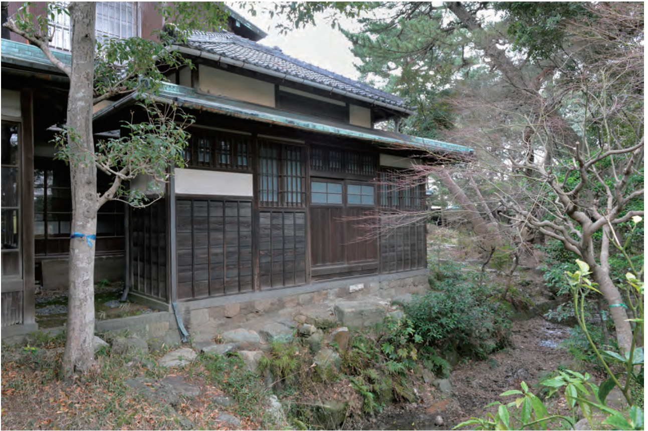
8. 風呂・便所棟 全景（北西より）
