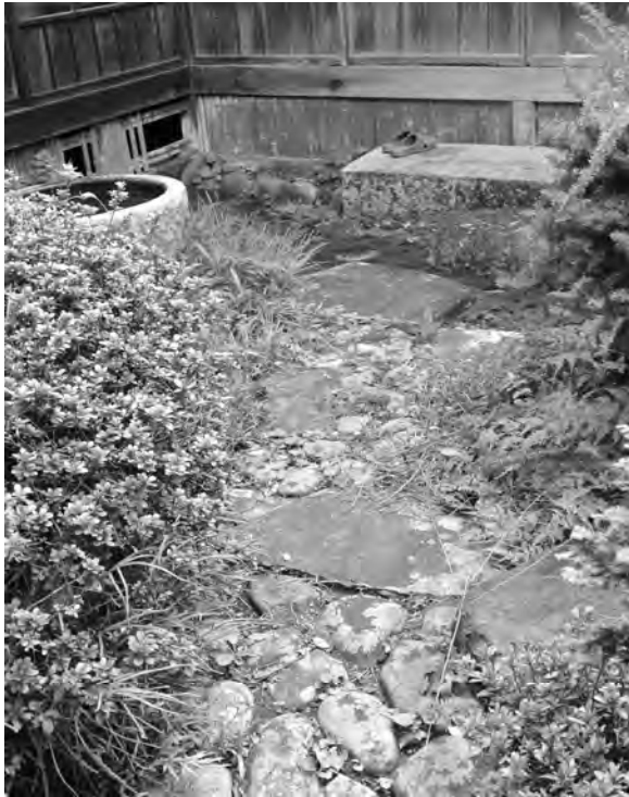
図 2-4 主屋北西の庭の沓脱ぎ石と霰こぼし
