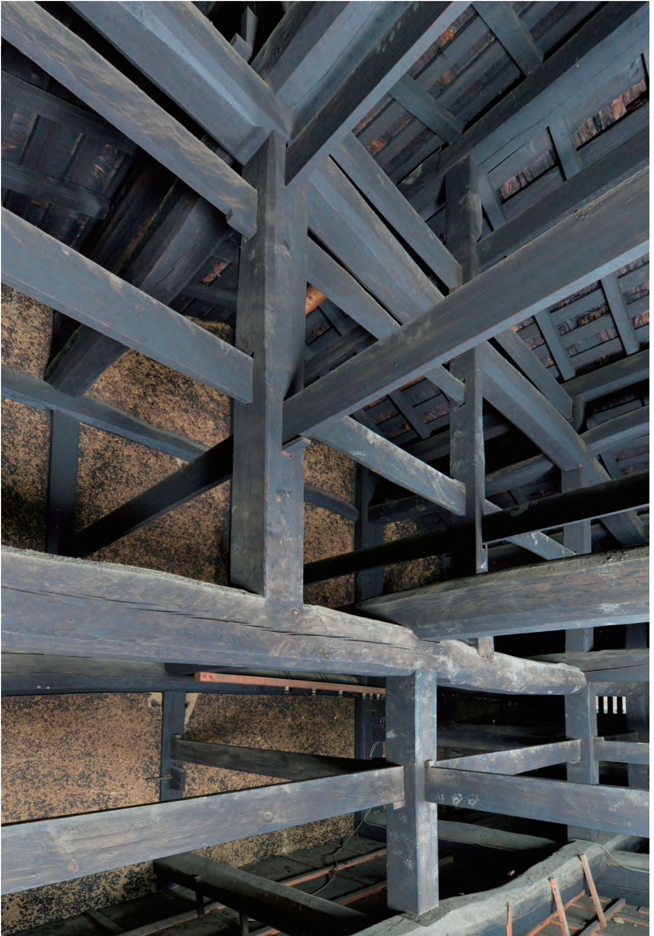
5. 主屋 土間側小屋組（南東より）
