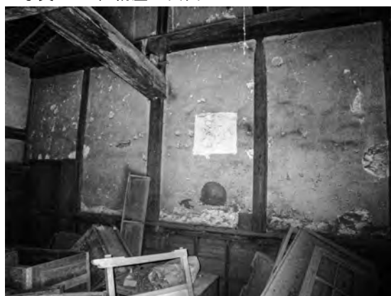
写真 2-21、納屋 北室南面
