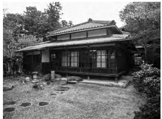
写真 2-8、奥座敷棟 西面
