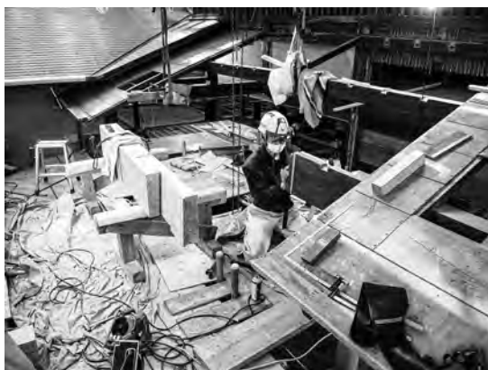
写真 3-8、軒桁継木状況
