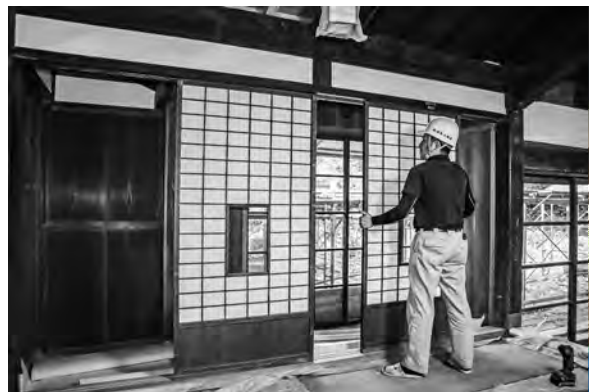
写真 3-22、障子建付調整状況
