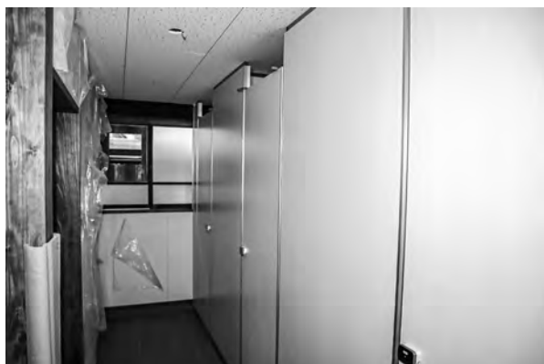
写真 3-24、便所間仕切りブース新設
