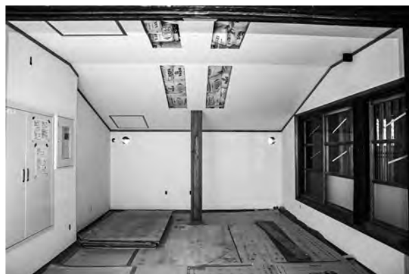
写真 3-23、管理室クロス張り新設
