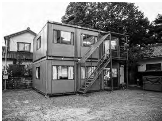
写真 3-2、作業員詰所・現場事務所
