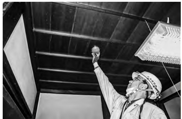
写真 3-27、自動火災報知設備設置状況
