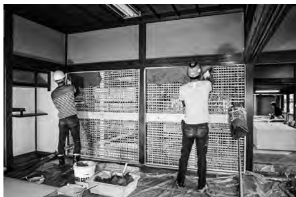
写真 3-18、荒壁土塗状況
