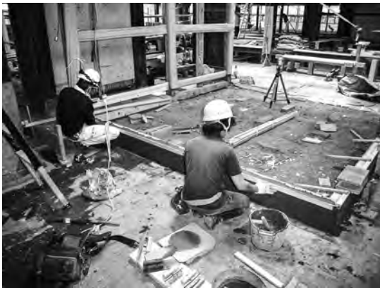
写真 3-4、コンクリートブロック新設状況
