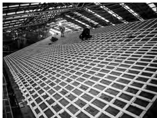
写真 3-11、空葺下地状況
