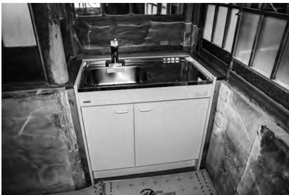
写真 3-28、給湯室流し台新設
