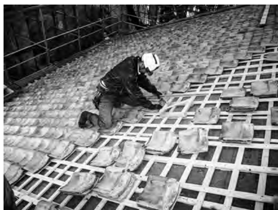
写真 3-12、棧瓦葺状況
