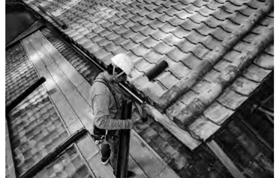
写真 3-15、塩ビ製内樋新設状況
