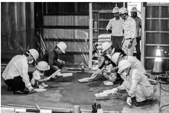
写真 3-30、三和土体験会状況
