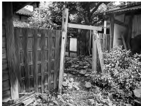
写真 2-34、露地門・袖塀 北面
