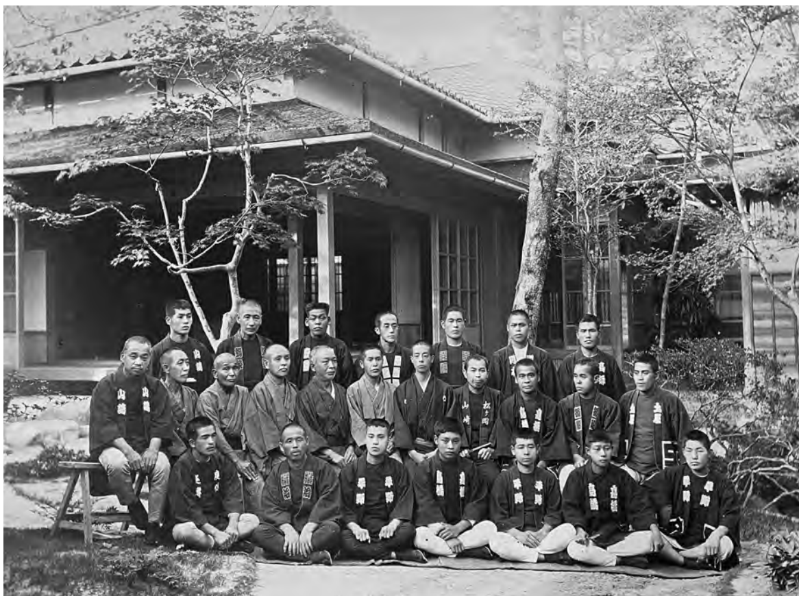
図2-17、奥座敷棟竣工時と推測される古写真（年代不明） 個人蔵 上段左から2人目は銅板職人で、この古写真はその御子孫の所有である
