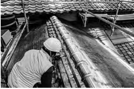
写真 3-14、大棟銅瓦葺状況
