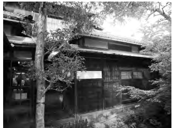
写 2-12、風呂便所棟 西面
