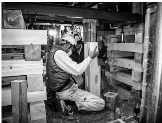
写真 3-6、柱根継状況
