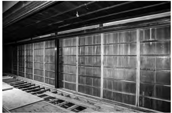
写真 3-21、雨戸建付調整完了
