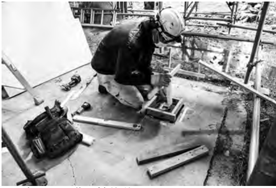
写真 3-3、礎石補修状況
