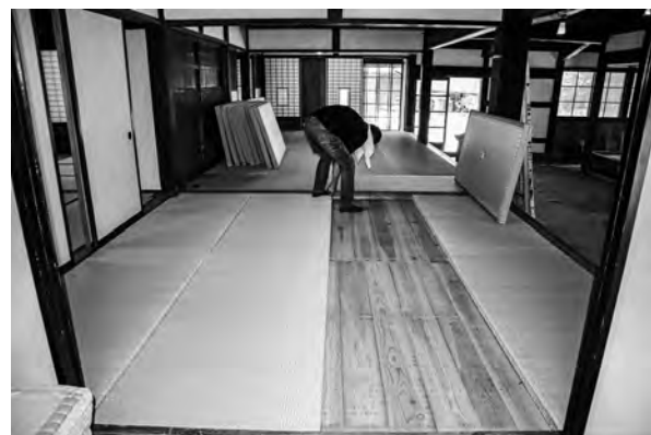
写真 3-26、畳敷き込み状況
