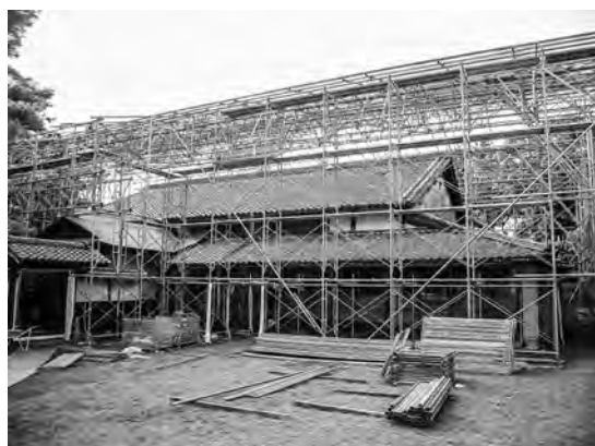
写真 3-1、素屋根架設状況
