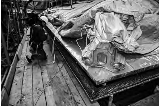
写真 3-16、落ち葉除けネット新設状況
