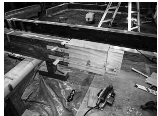
写真 3-7、差し敷居継木状況
