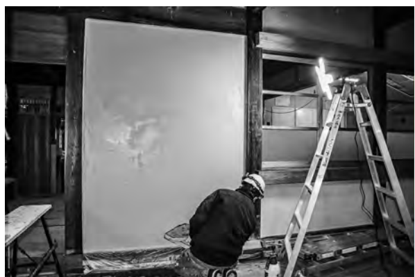
写真 3-20、半田上塗状況
