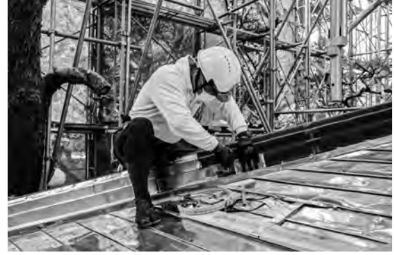
写真 3-13、隅棟銅瓦葺状況
