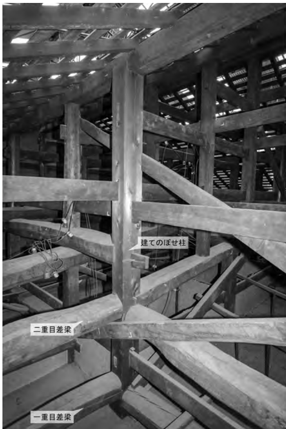
写真 3-3、建てのぼせ柱「り・四」と差梁
