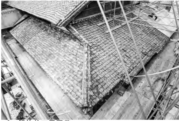
2、解体前下屋瓦葺
