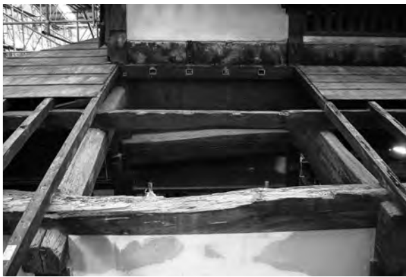
6、北下屋東側軒桁・母屋
