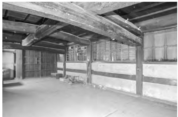
27-2、修理前 ツシニ階 南東面
