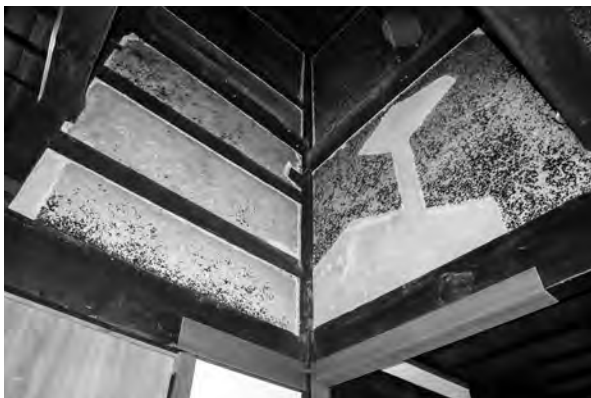
6、中塗・塵廻り部分補修
