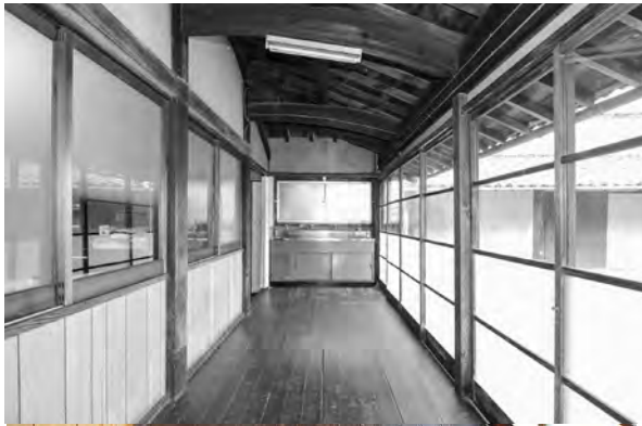
1、東面 28-2、修理前 土庇
