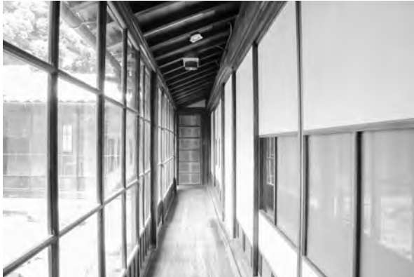
1、東面 17-1、竣工 北縁（西）
