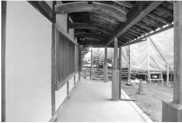
1、東面 28-1、竣工 土庇
