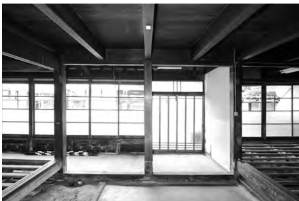
3、南面 33、後補材撤去 前庭
