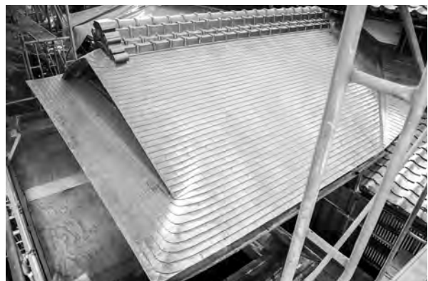
7、式台屋根棟銅瓦葺替
