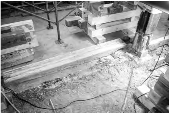
4、番頭部屋南面土台解体
