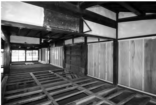
3、南面 32、後補材撤去 台所
