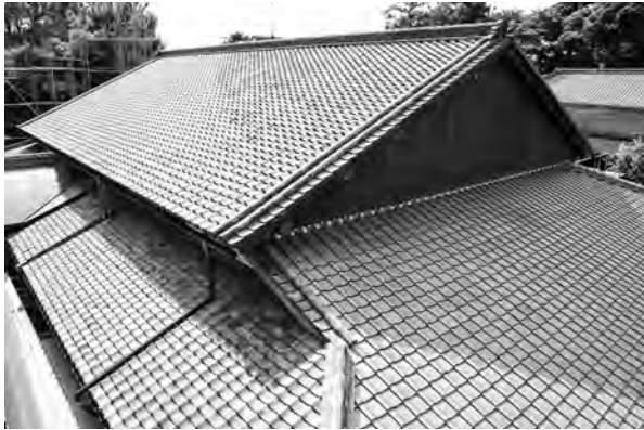
4、上屋・下屋瓦葺替
