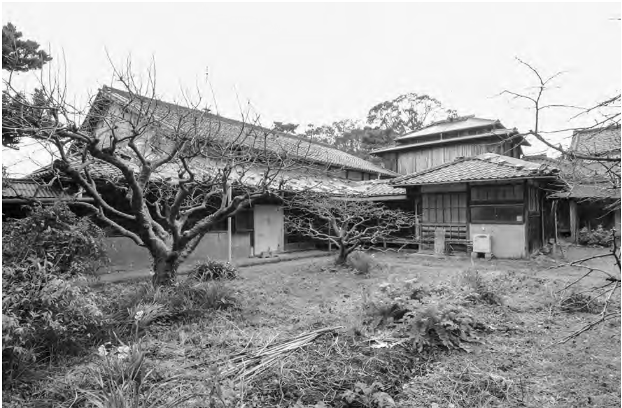
5-2、修理前 外観 北東面
