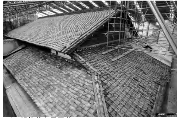
1、解体前上屋瓦葺
