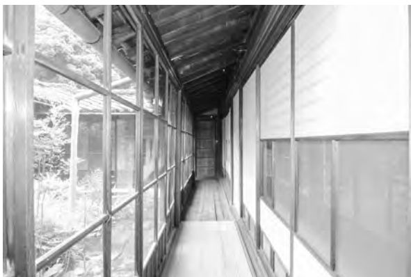
1、東面 17-2、修理前 北縁（西）
