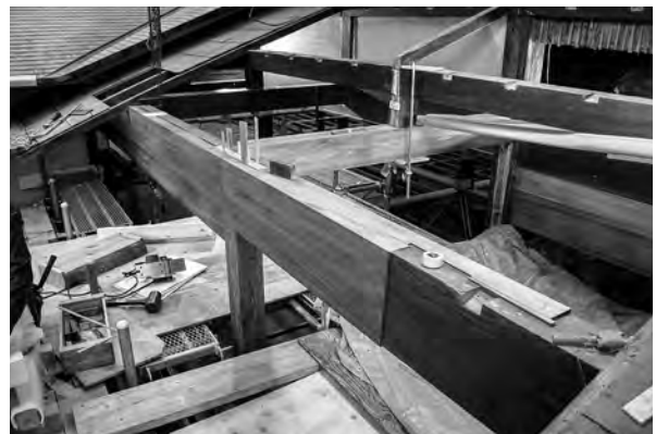
5、仕事場南面軒桁・繋ぎ梁取替、土庇軒桁継木
