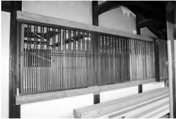
2、土庇北面格子戸修理・復原
