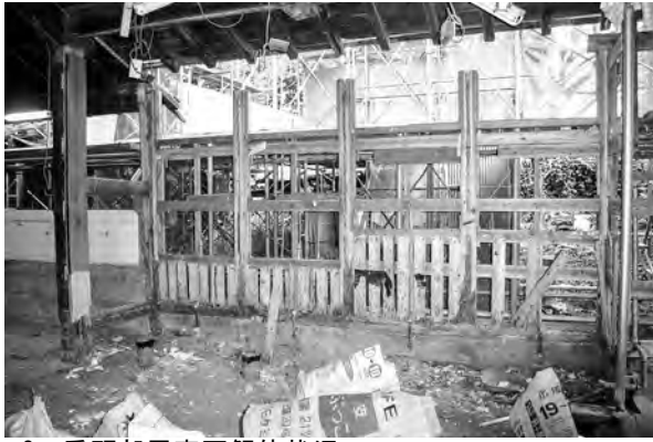
2、番頭部屋東面解体状況
