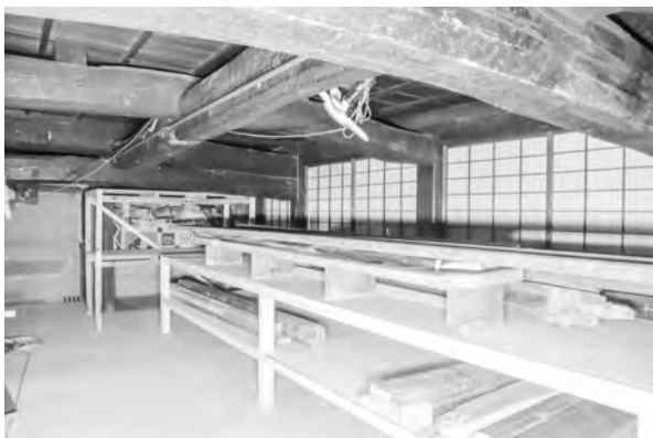
27-1、竣工 ツシニ階 南東面
