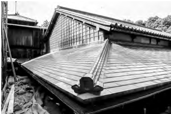
6、南西下屋銅板葺替
