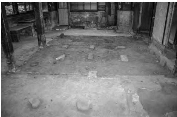
3、向い台所 29、後補材撤去 土間
