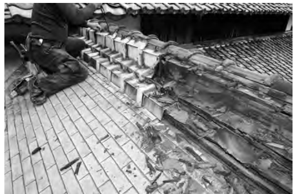
7、式台屋根棟銅瓦
