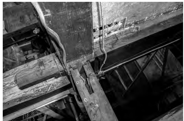
7、ツシニ階「は九」柱・差し鴨居北東面仕口
