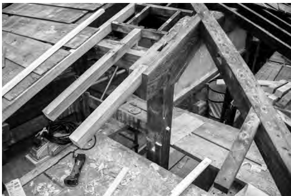
6、炊事場北面根曲り軒桁矧木
