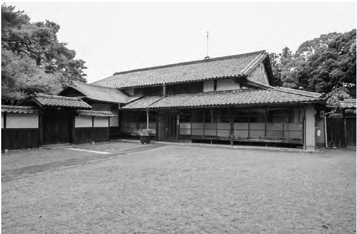
1-2、修理前 外観 南面
