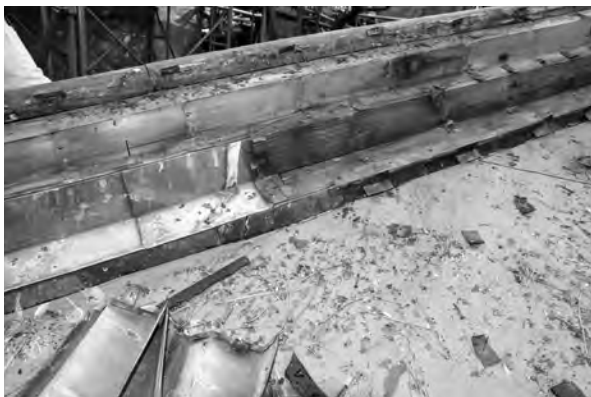
8、下屋南西隅銅瓦
