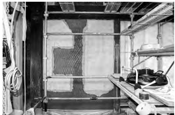
5、荒壁部分補修
