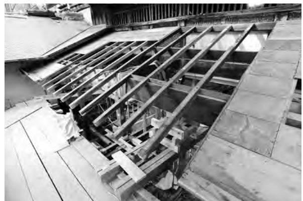
7、南下屋東側垂木
