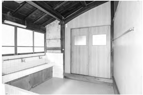
25-2、修理前 女中部屋（便所）南東面
