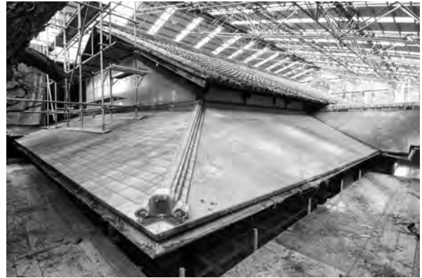
1、解体前南西下屋銅板葺
