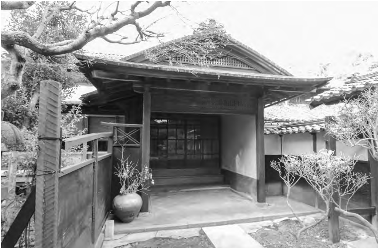
2-2、修理前 外観 式台
