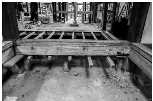
5、仕事場西面差し敷居解体前
