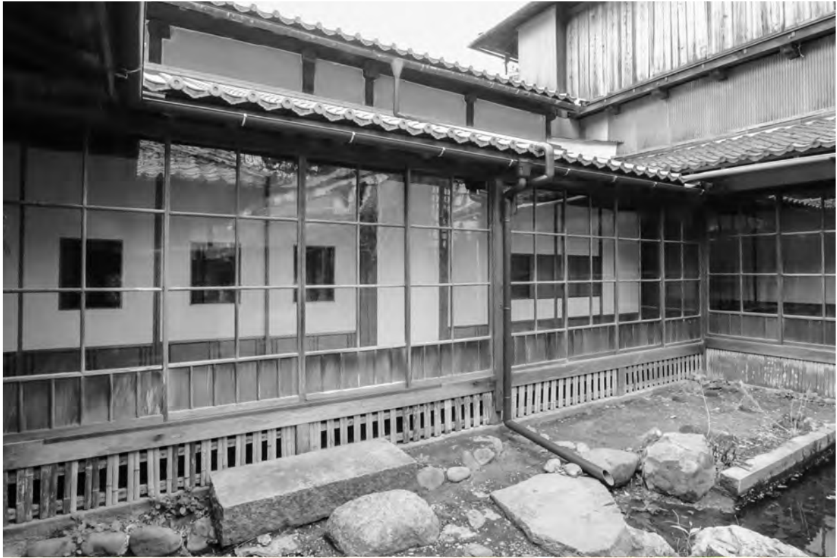
6-1、竣工 外観 北面西側
