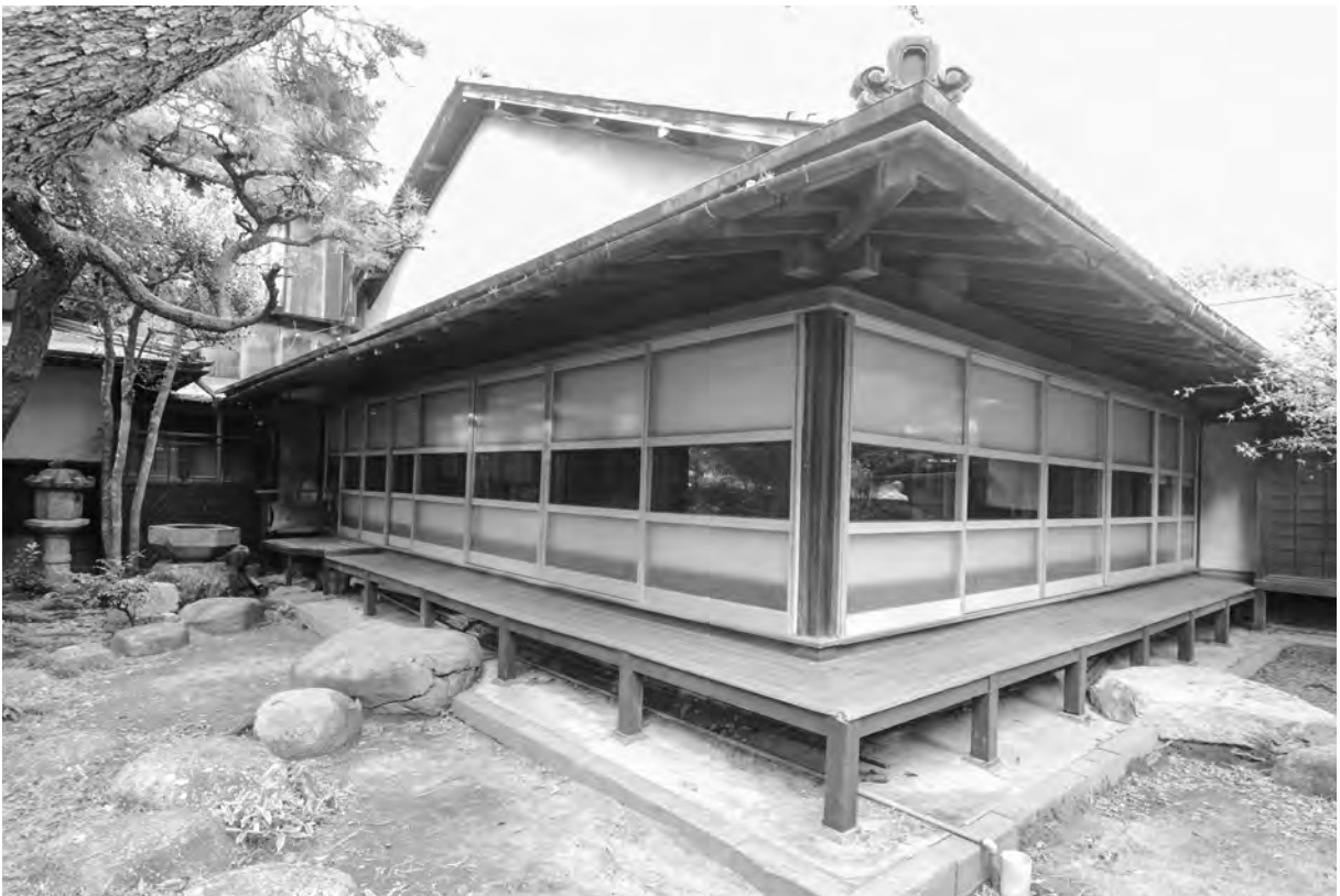
3-2、修理前 外観 南西面
