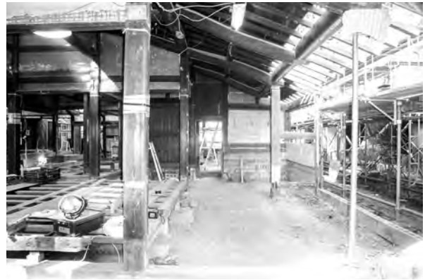
3、番頭部屋東面解体完了
