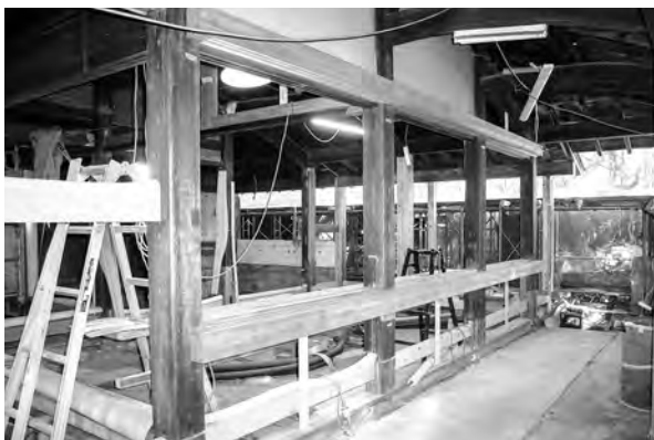
8、土庇北面雨戸敷居・鴨居復原
