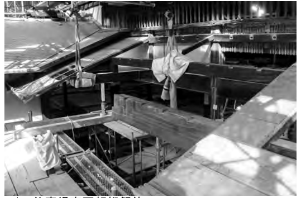
1、仕事場南面軒桁解体
