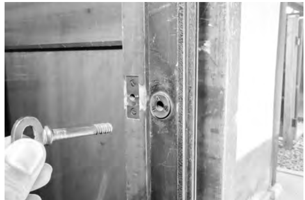
3、取次南面ガラス戸ネジ締め
