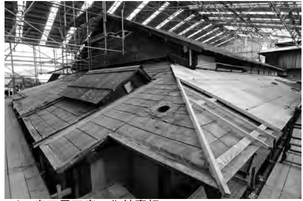
1、東下屋天窓・化粧裏板
