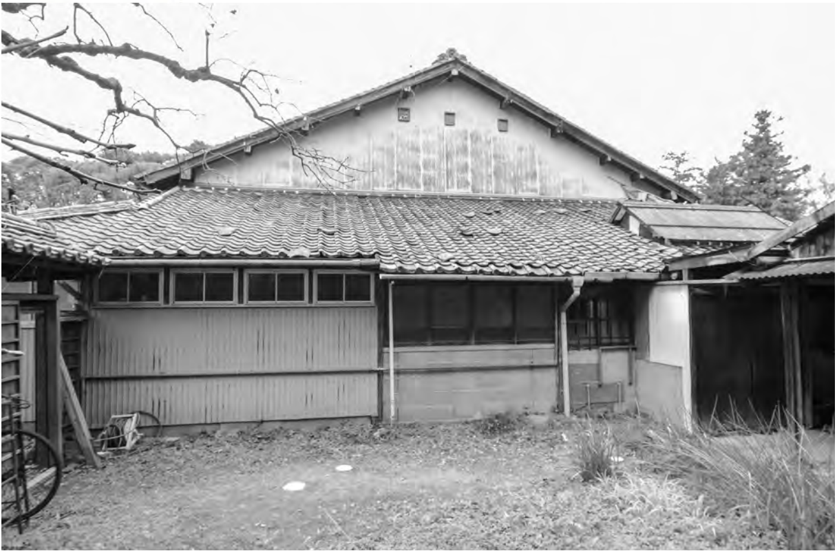
4-2、修理前 外観 東面
