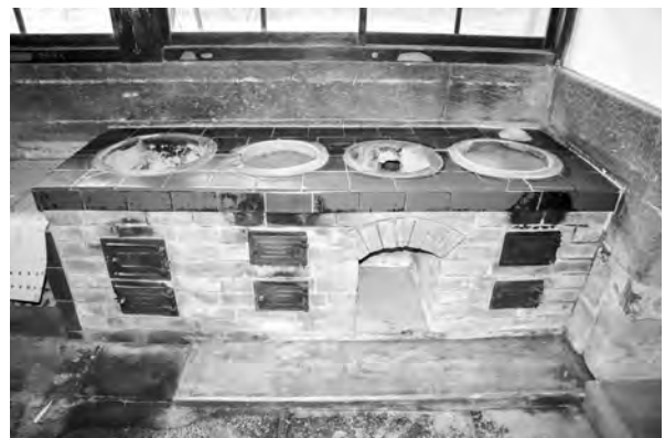
7、カマド部分補修
