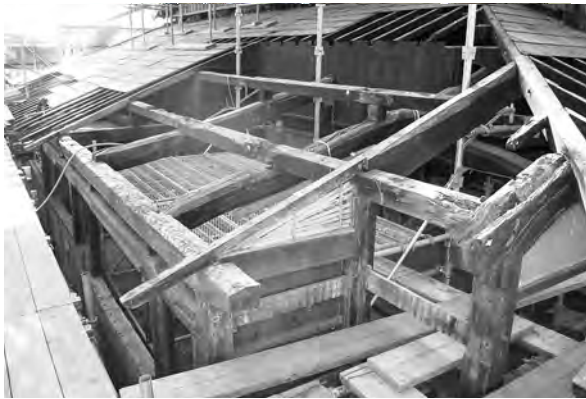
4、東下屋軒桁・母屋
