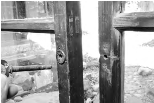
4、北縁（西）ガラス戸ネジ締め 50、建具修理
