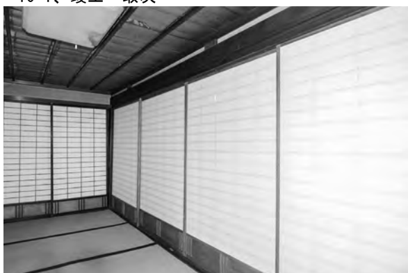
1、北西面 10-2、修理前 取次
