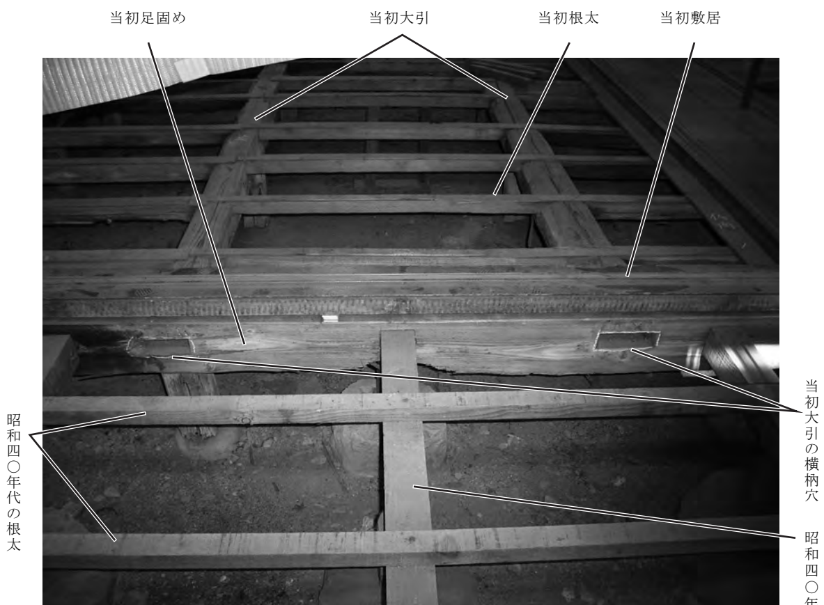
147、当初足固め 手前が八畳、奥が仏間 八畳～仏間境の当初足固め南面に修理で取外された大引の横柄穴が残る
