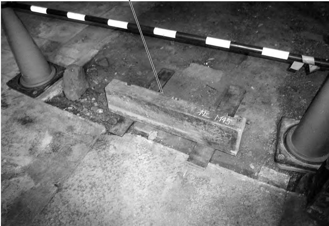
106、向い台所北面東側差し敷居
