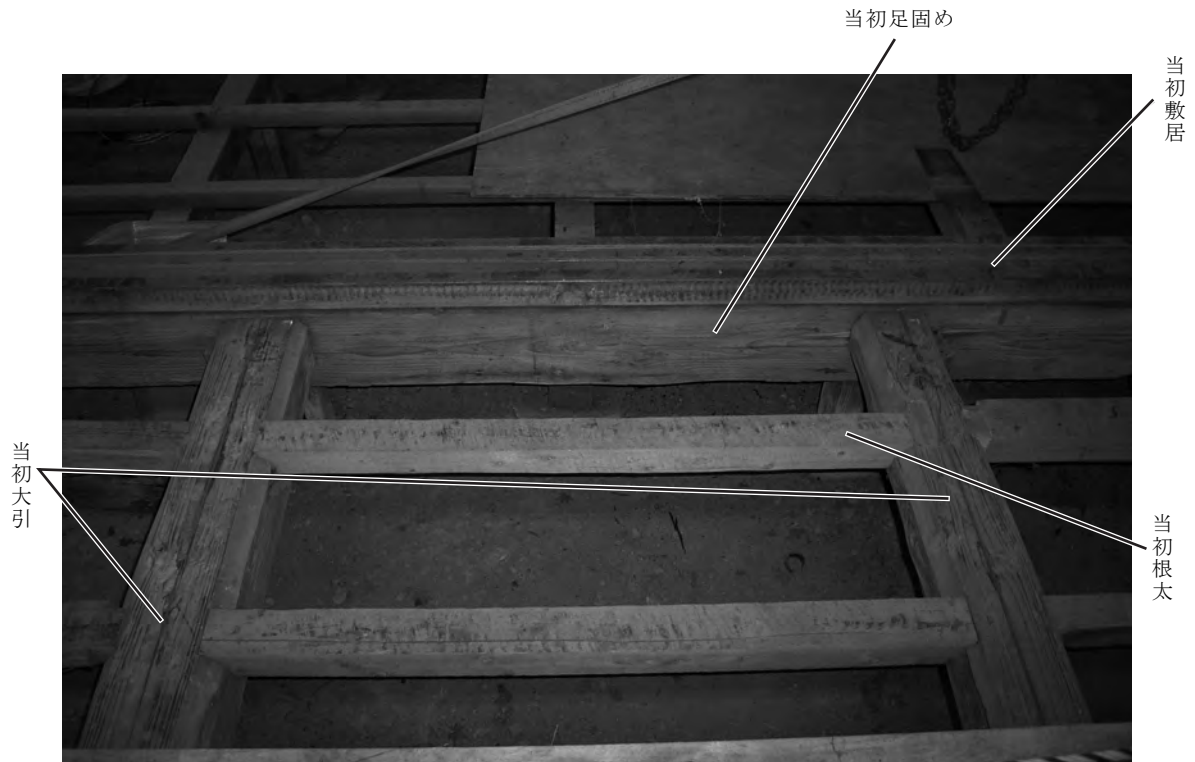
148、当初大引 手前が十畳、奥が八畳 十畳～八畳境の当初足固め南面に当初大引が納まる
