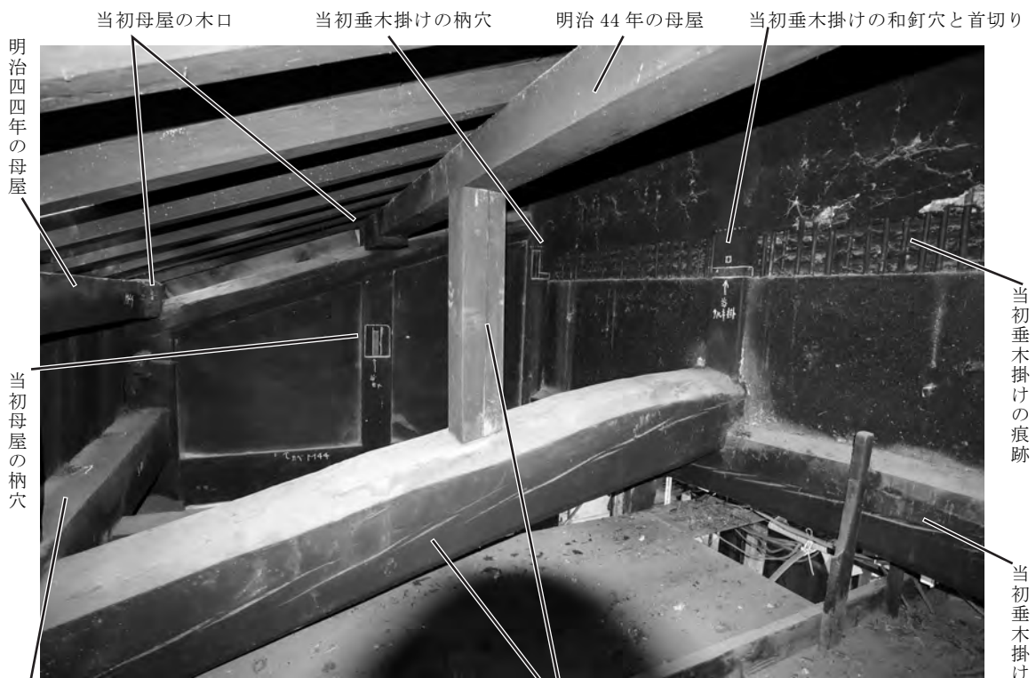
当初軒桁の垂木彫りと和釘穴
