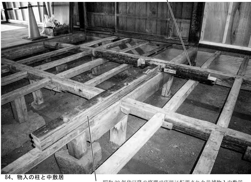
昭和 30 年代以降の修理で床組に転用された後補物入北東隅柱
