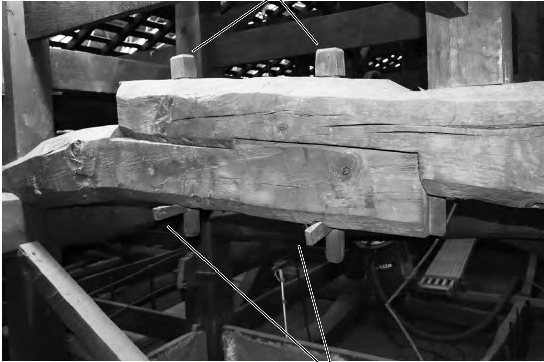
152、敷桁・敷梁と差桁・差梁継手詳細
