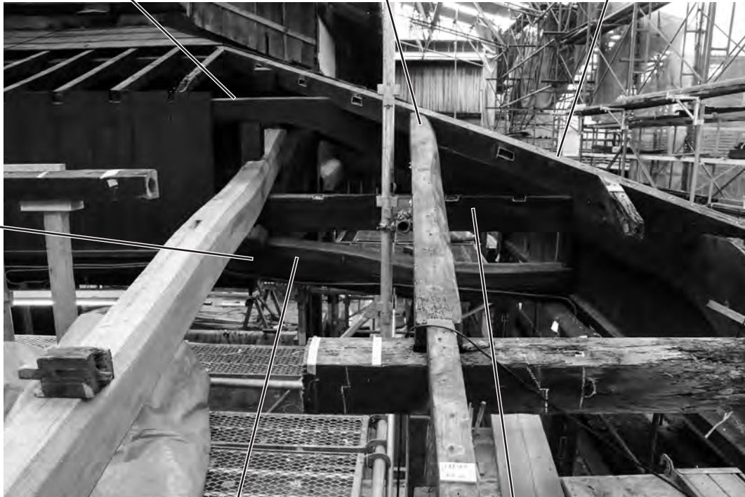
111、下屋北東隅東面
