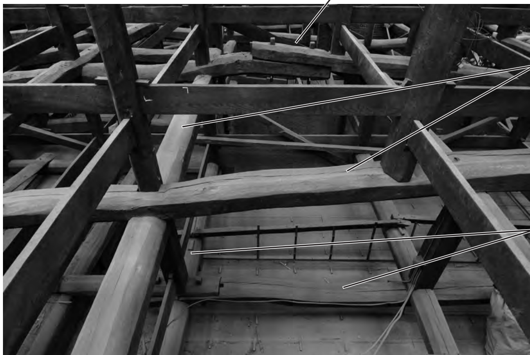
151、敷桁・敷梁と差桁・差梁
