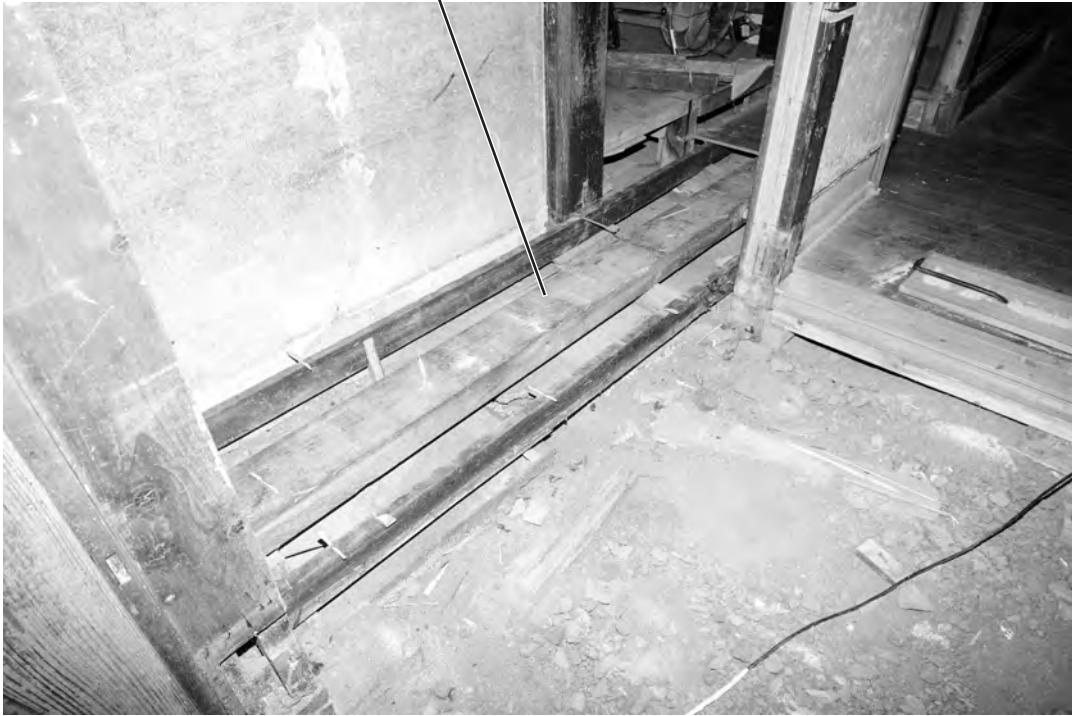
105、向い台所東面差し敷居
