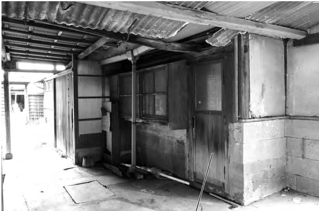
96、炊事場東面外部
