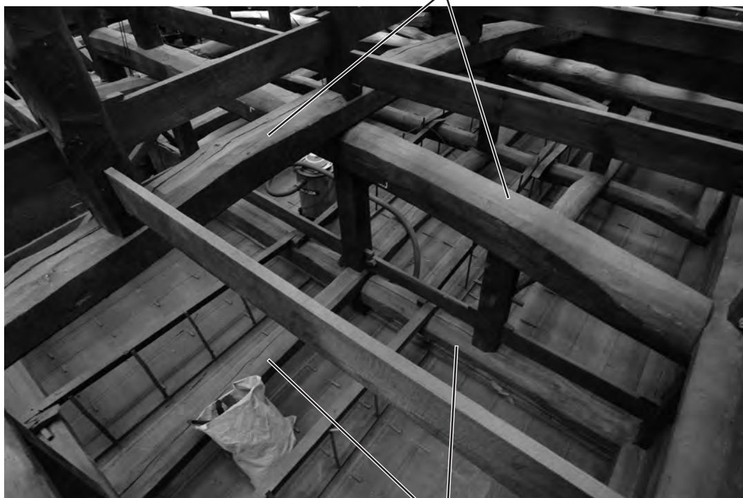
150、敷桁・敷梁と差桁・差梁
