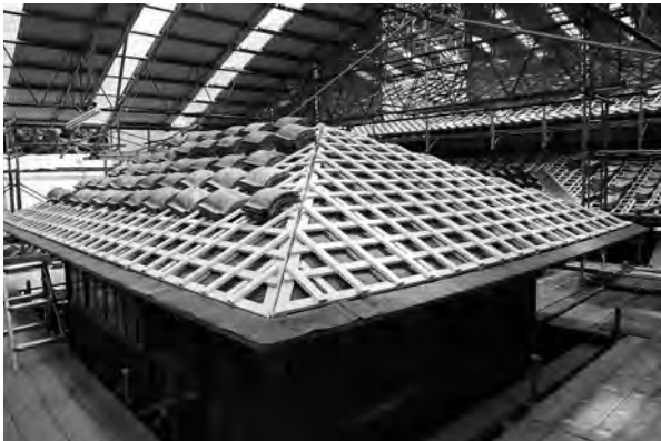
3、主屋部北西面 18、土居葺・瓦空葺下地
