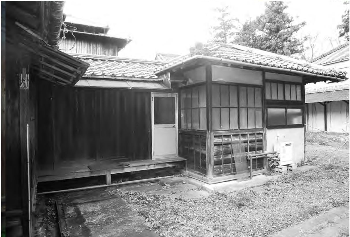
4-2、修理前 外観 南東面
