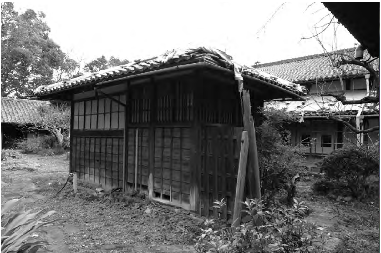
2-2、修理前 外観 北西面
