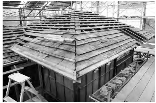
1、主屋部南東面
