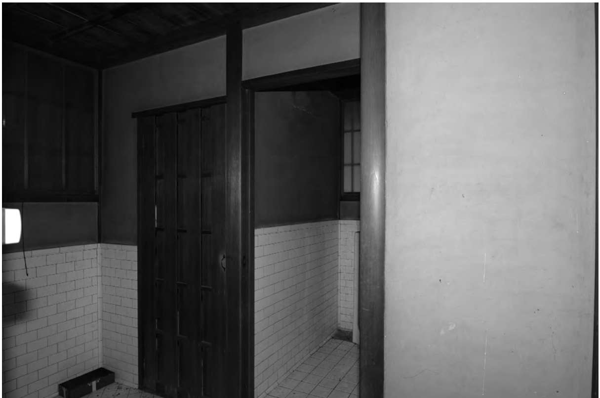
5-2、修理前 便所前室 北面
