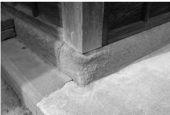
4、便所前室床下 写真 2-2、礎石
