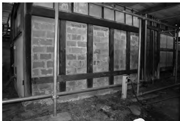
3、風呂北面外部
