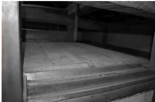
2、奥座敷棟奥座敷壁面上部幕板換気口天井裏 写真 2-5、面戸鉄製網
