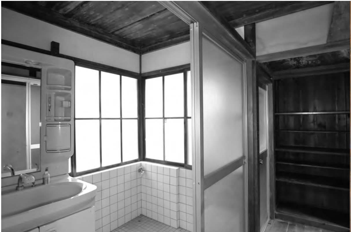
7-1、修理前 脱衣室・廊下 南東面
