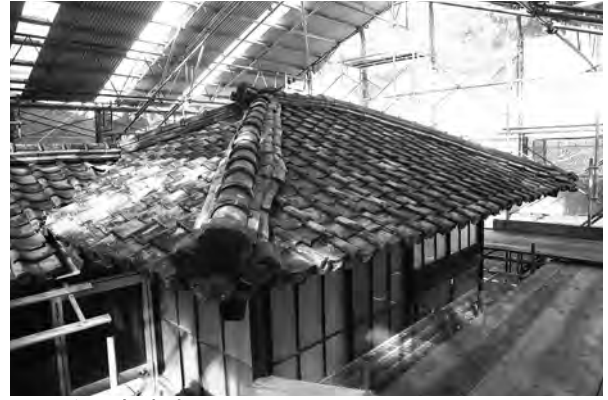
2、主屋部南東面
