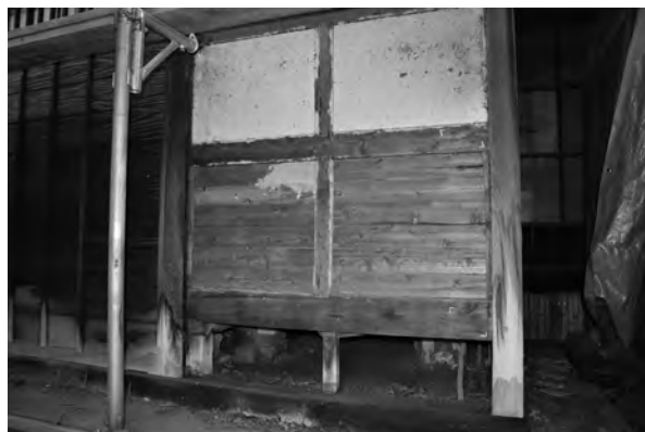
1、便所前室西面外部
