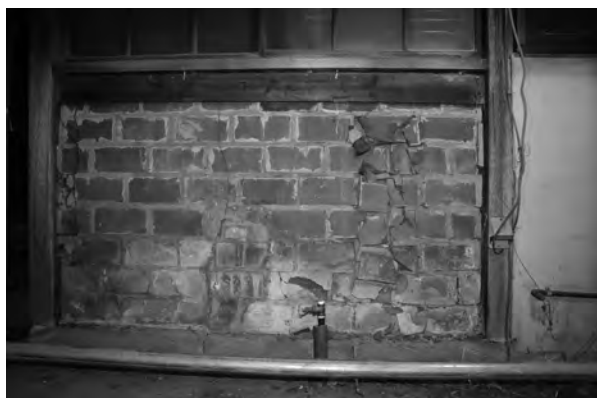
4、洗面室東面外部
