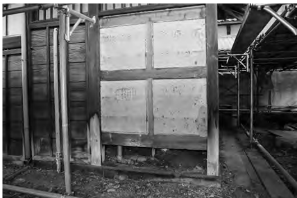
2、便所（西）北面外部
