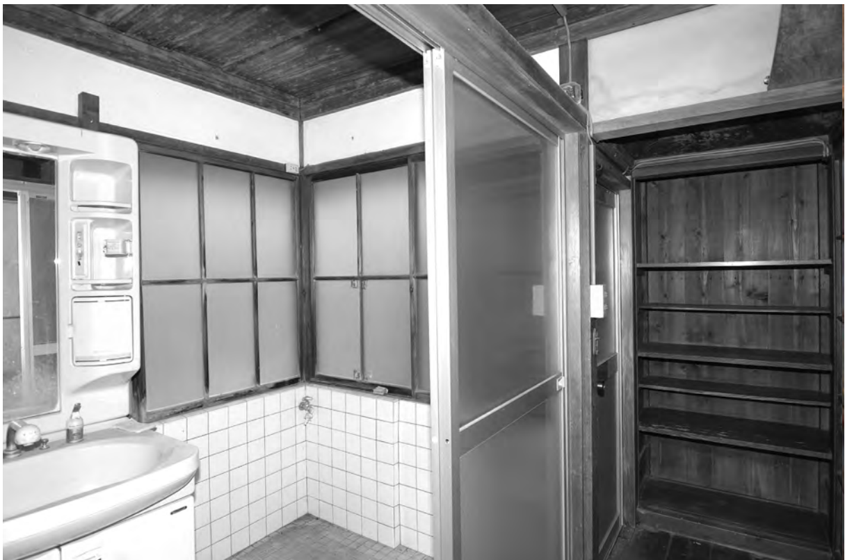
7-2、修理前 脱衣室・廊下 南東面
