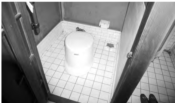
2、便所（西）床・腰タイル
