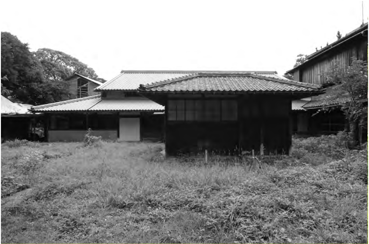
3-1、竣工 外観 北面
