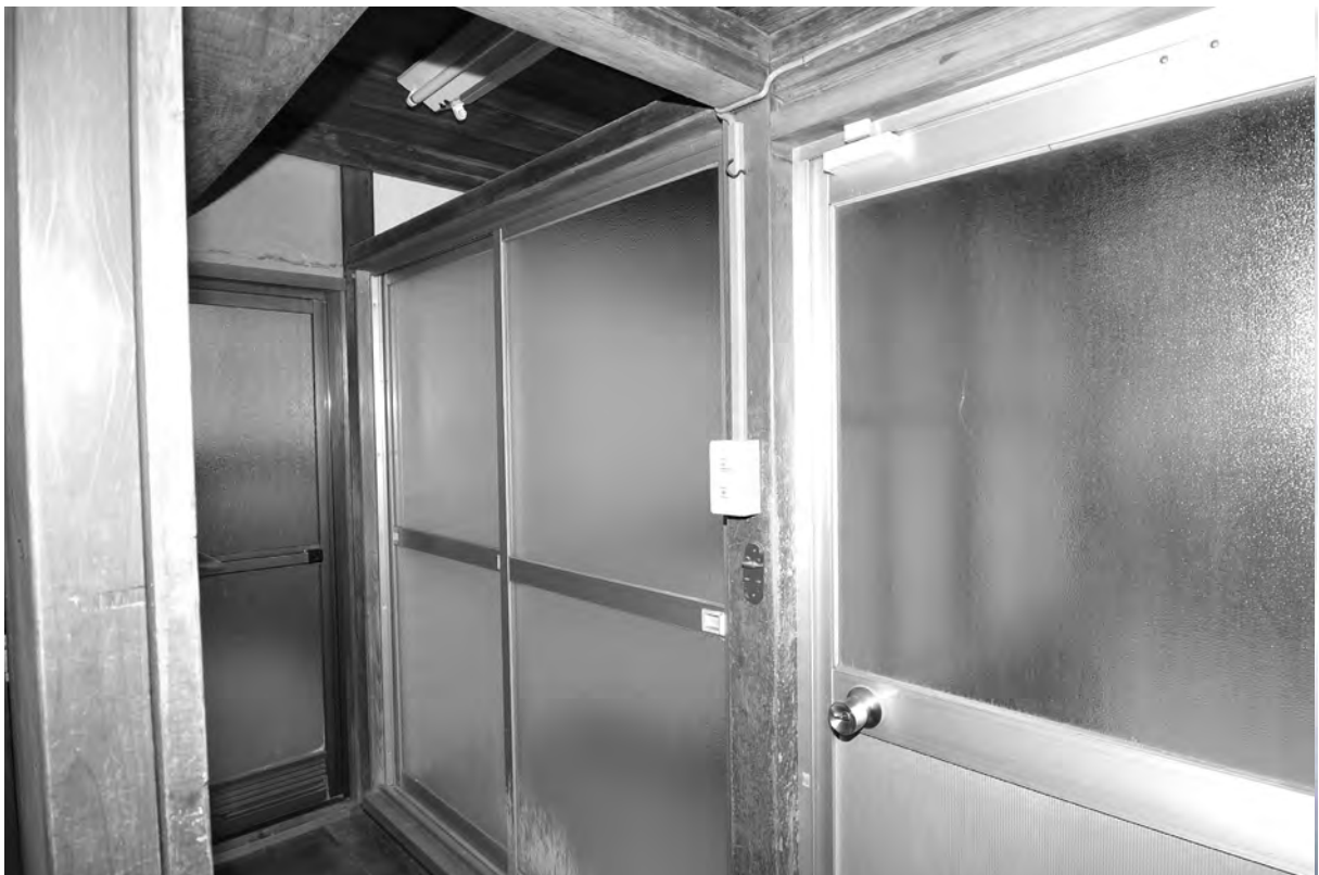
8-2、修理前 廊下 北東面
