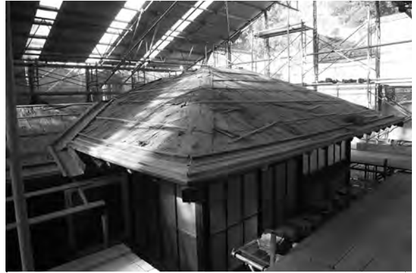
2、主屋部南東面
