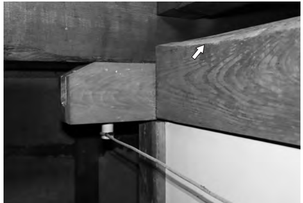
2、奥座敷棟軒桁上端 写真 2-3、軒桁上端
