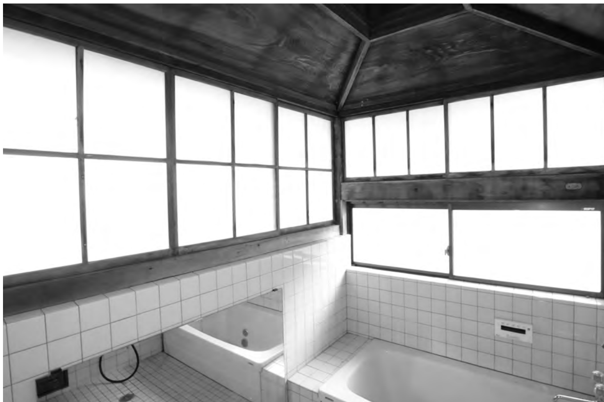
9-1、竣工 風呂 北東面
