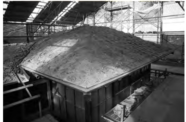
2、主屋部南東面
