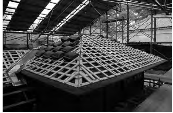
2、主屋部南東面
