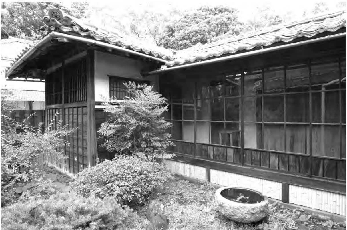
1-2、修理前 外観 南西面
