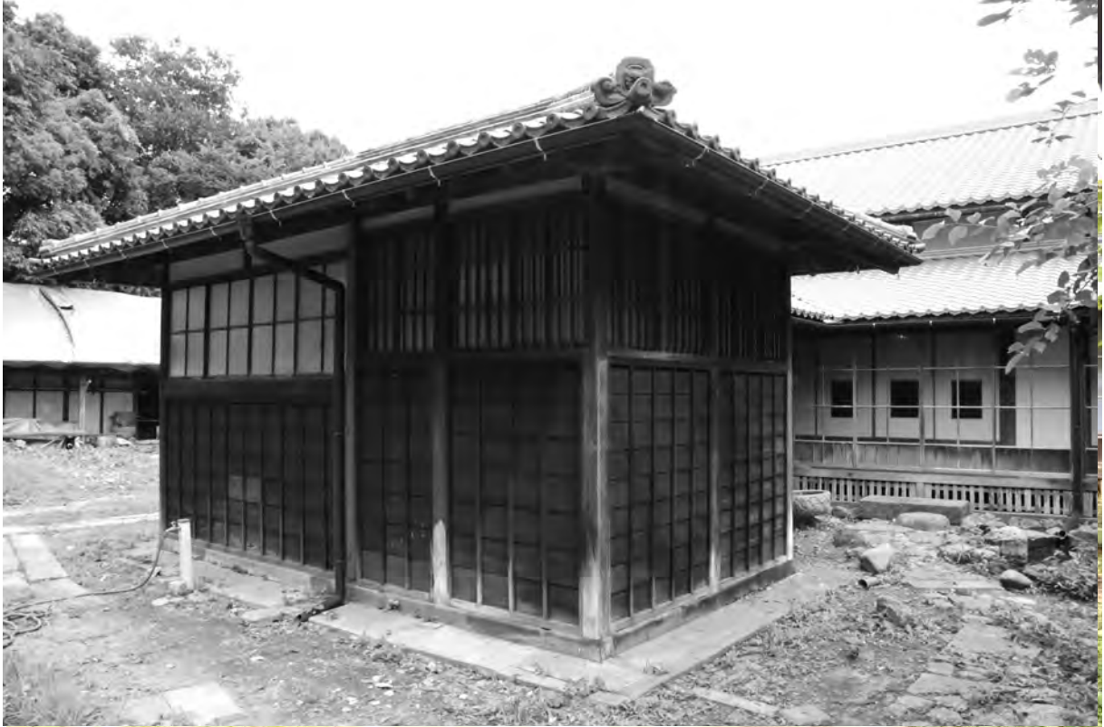
2-1、竣工 外観 北西面
