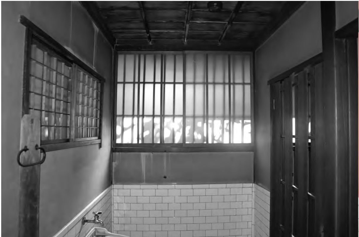
6-1、竣工 便所前室 西面
