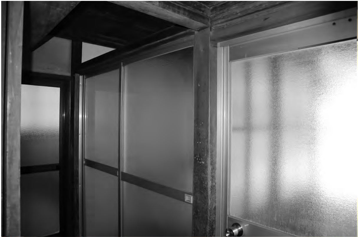
8-1、竣工 廊下 北東面
