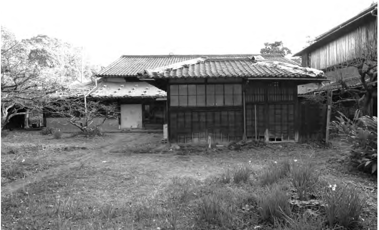
3-2、修理前 外観 北面
