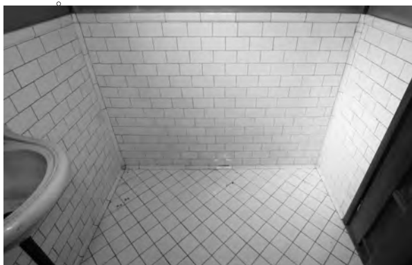
1、便所前室床・腰タイル
